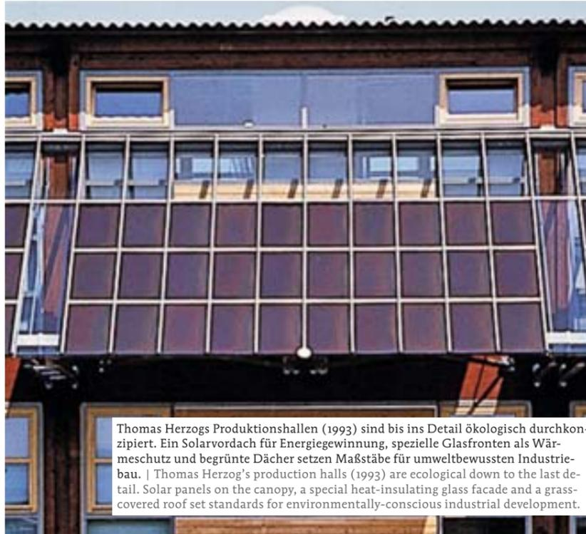
Thomas Herzogs Produktionshallen (1993) sind bis ins Detail ökologisch durchkonzipiert. Ein Solarvordach für Energiegewinnung, spezielle Glasfronten als Wärmeschutz und begrünte Dächer setzen Maßstäbe für umweltbewussten Industriebau. | Thomas Herzog's production halls (1993) are ecological down to the last detail. Solar panels on the canopy, a special heat-insulating glass facade and a grass-covered roof set standards for environmentally-conscious industrial development.
