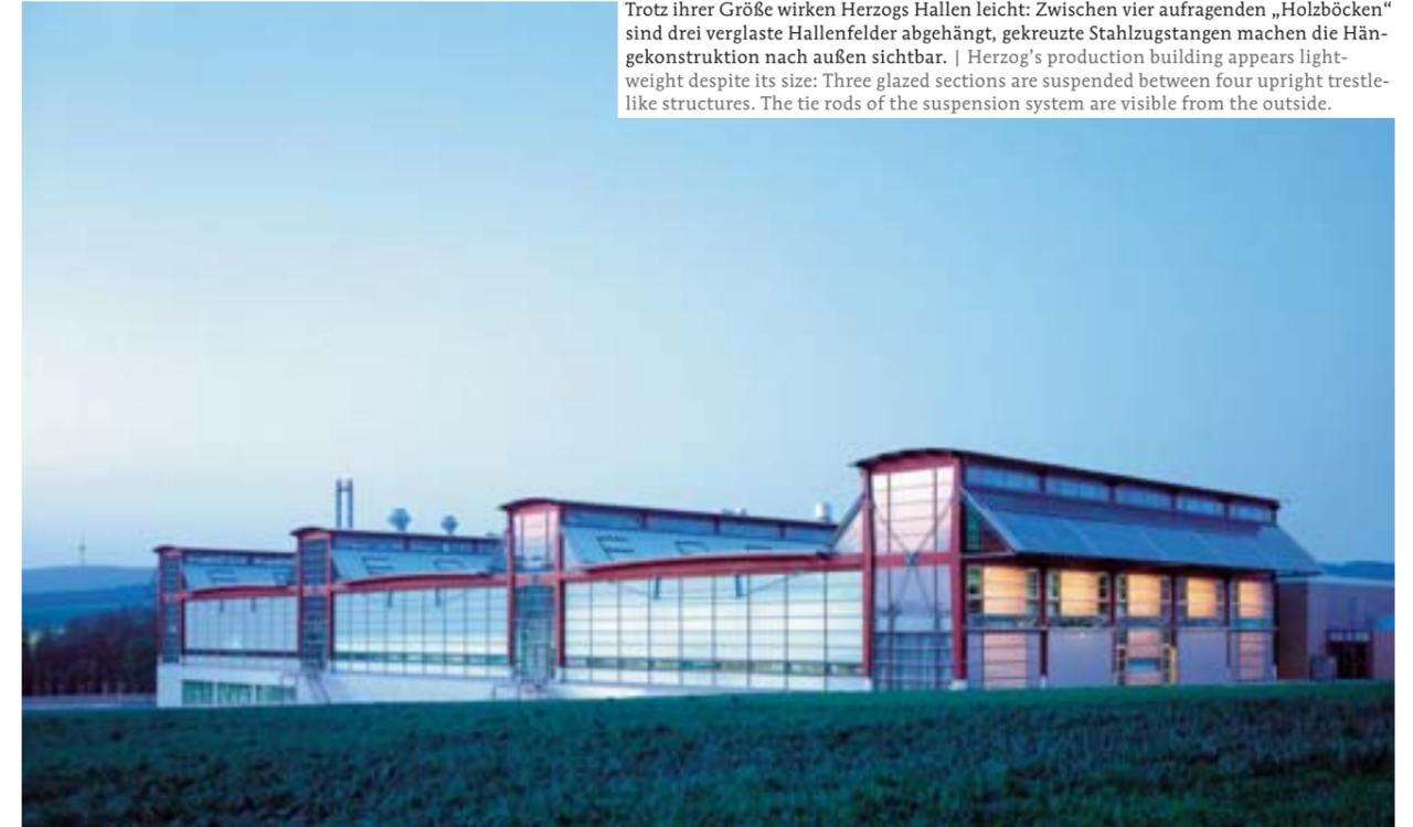
Trotz ihrer Größe wirken Herzogs Hallen leicht: Zwischen vier aufragenden „Holzböcken“ sind drei verglaste Hallenfelder abgehängt, gekreuzte Stahlzugstangen machen die Hängekonstruktion nach außen sichtbar. | Herzog's production building appears lightweight despite its size: Three glazed sections are suspended between four upright trestle-like structures. The tie rods of the suspension system are visible from the outside.
